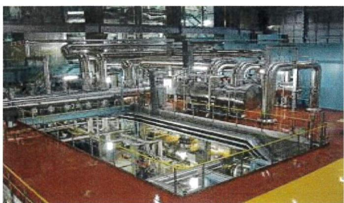
Forsthaus エネルギーセンターは、廃棄物、地域の木材、天然ガスを、電気、蒸気、地域暖房に変換する。このおかげで、海外からの電力輸入が大幅に削減された。さらに電力供給の総CO2排出量は、年間57,000トン減少している。廃棄物焼却プラント(KVA)は、熱電併給プラント(CHP)およびガスと蒸気の複合サイクル発電プラント(CCGT)と組み合わされているため、季節と顧客の需要に応じて、地域暖房・電気の生産量を調整することが可能である。また、グリーン電力として、太陽光発電システムもエネルギーセンターの屋根で生成されている。
