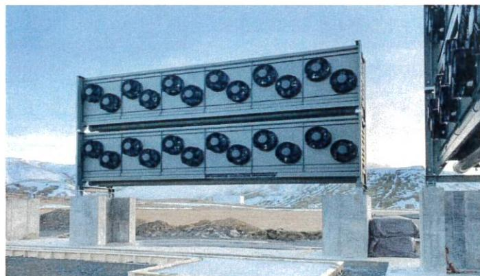
クライムワークス (Climeworks) は、大気中の二酸化炭素 (CO<sub>2</sub>) を回収して「製品化」する世界初の商用プラントを設計。CO<sub>2</sub>を貴重な資源に変えるイノベーション。チューリッヒ州ヒンヴィールのごみ焼却施設の屋上に設置された装置は、2017年6月に稼働を開始した。特殊なフィルターでCO<sub>2</sub>を空気中の他の分子と分離して回収することで、大気中の温室効果ガスの削減に貢献している。全18機のモジュールはそれぞれ年間最大50トンのCO<sub>2</sub>を吸収できる。これは1ヘクタールの森林が吸収する量の2倍に相当する。回収したCO<sub>2</sub>は近くのビニールハウスにパイプで送られ、野菜の成長を促進する「肥料」になる。その他に、食品・飲料業界、エネルギー分野、自動車業界でも使用可能。
